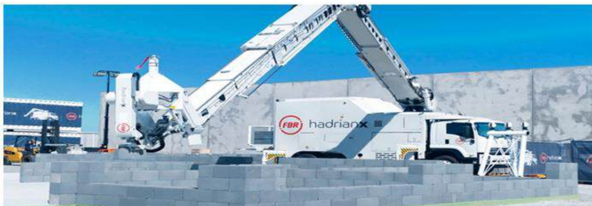
Рисунок 1.- Строительный робот HandrianX.
