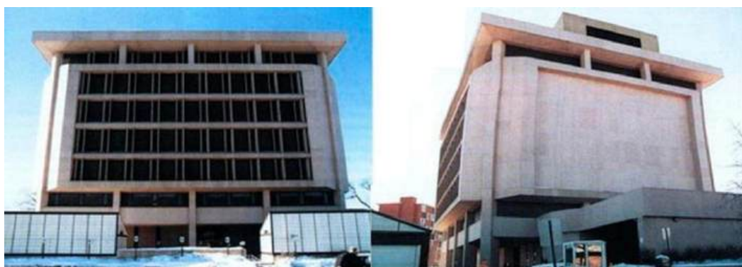
Рис. 2. Первое демонстрационное энергоэффективное здание - Офисное здание в США
